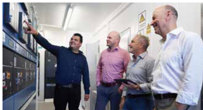
Entegra a Eplan úzko spolupracujú na vytvorení „šablóny projektu“. To pomáha zaisťovať, aby sa rozvodné siete mohli rozširovať aj v budúcnosti – s vysokou efektívnosťou inžinierskej práce.
