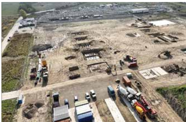
Stavenisko na mieste budúcej elektrickej stanice vo Vajnoroch v októbri 2025
