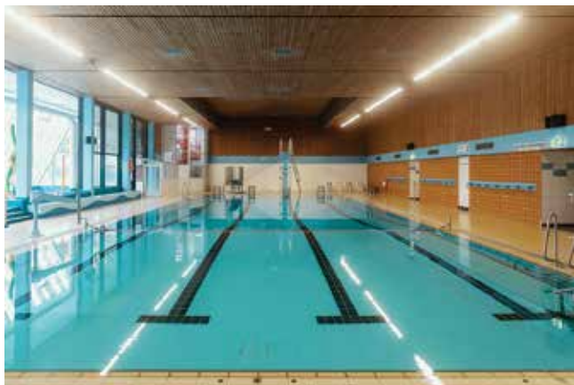
Rekreačné plavecké centrum Saterland bolo v roku 2017 vybavené energeticky úsporným vetracím systémom od spoločnosti HANSA Klimasysteme.
