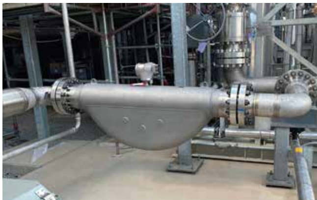
Coriolisov prietokomer Proline Promass F používaný za bodom vstrekovania vodíka možno ľahko nahradiť bez úpravy potrubia prietokomerom Promass X s vyššou kapacitou, keď je proces miešania vodíka pripravený na expanziu.
